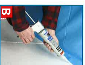
B Anwendungsbeispiel Probau®-Dampfbremsenkleber
