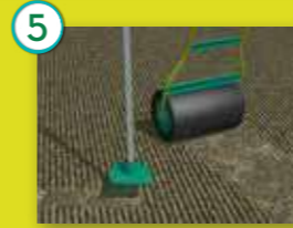
5 Compactar con un rodillo
