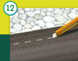
12 Ajustar las piezas entre sí, retirar el sobrante con un cúter
