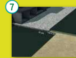
7 Solapar las firs de malla antihierbas unos 15 cm entre las firs
