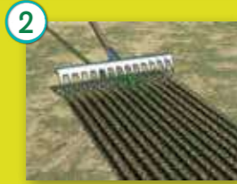
2 Remover la capa superficial para eliminar raíces
